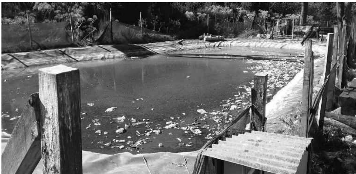
Foto N° 4: Pileta de lixiviados, Sitio M7
