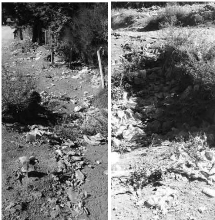
Foto N° 6: Canal de lixiviados proveniente de la celda de acopio y que llega hasta la alcantarilla de la RN N°40, el cual se encontraba seco.
